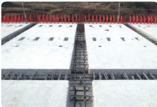
프리캐스트 바닥판 시공
